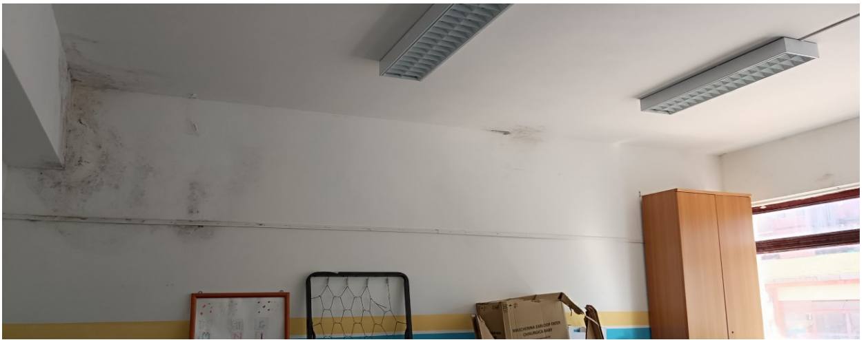
Vano scala e locale adiacente, piano primo pad. B
