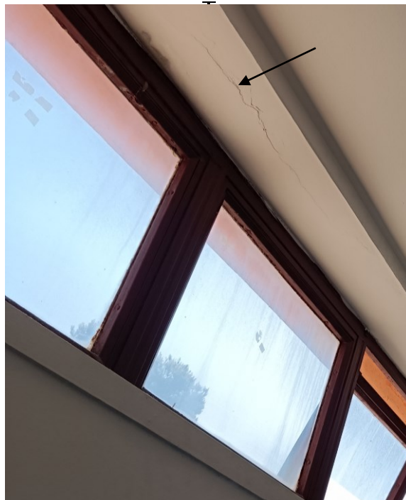
Corridoio piano primo pad. B
