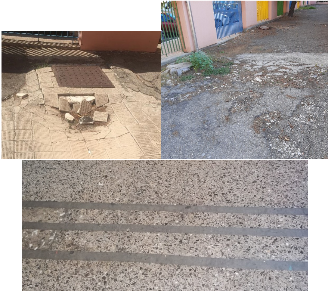
Tratto corridoio interno Pad. A
