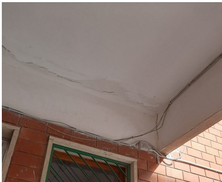
Pensilina di copertura in corrispondenza dell'ingresso principale
