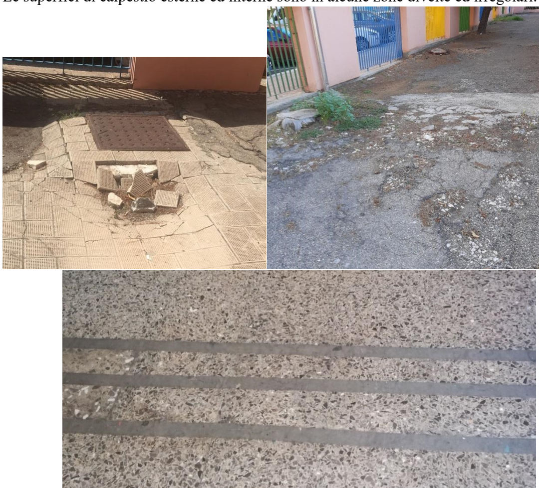
Tratto corridoio interno Pad. A
