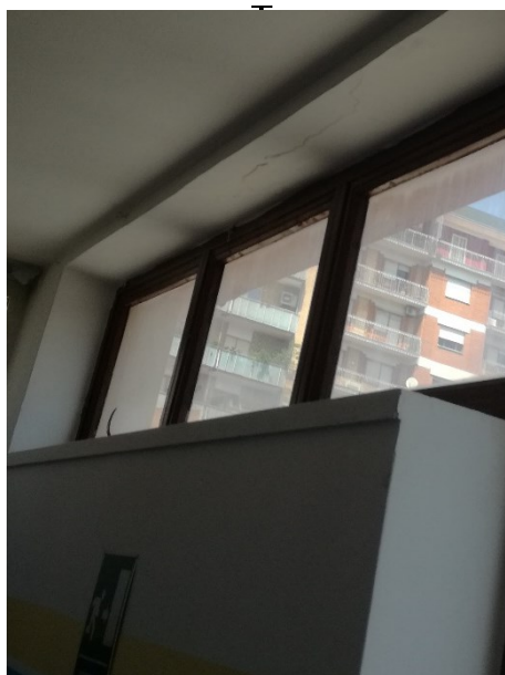
Corridoio piano primo pad. B
