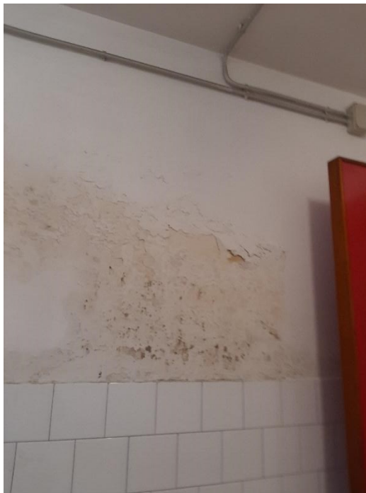
Servizi igienici alunni piano terra Pad. B
