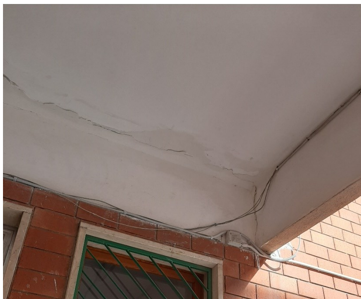
Pensilina di copertura in corrispondenza dell'ingresso principale
